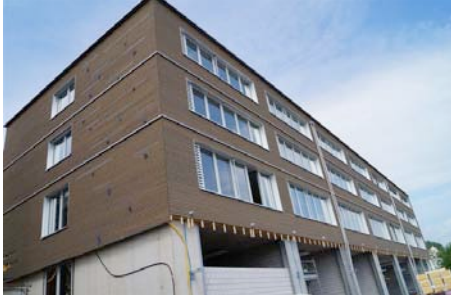
Juni 2013 – das Gerüst ist weg
