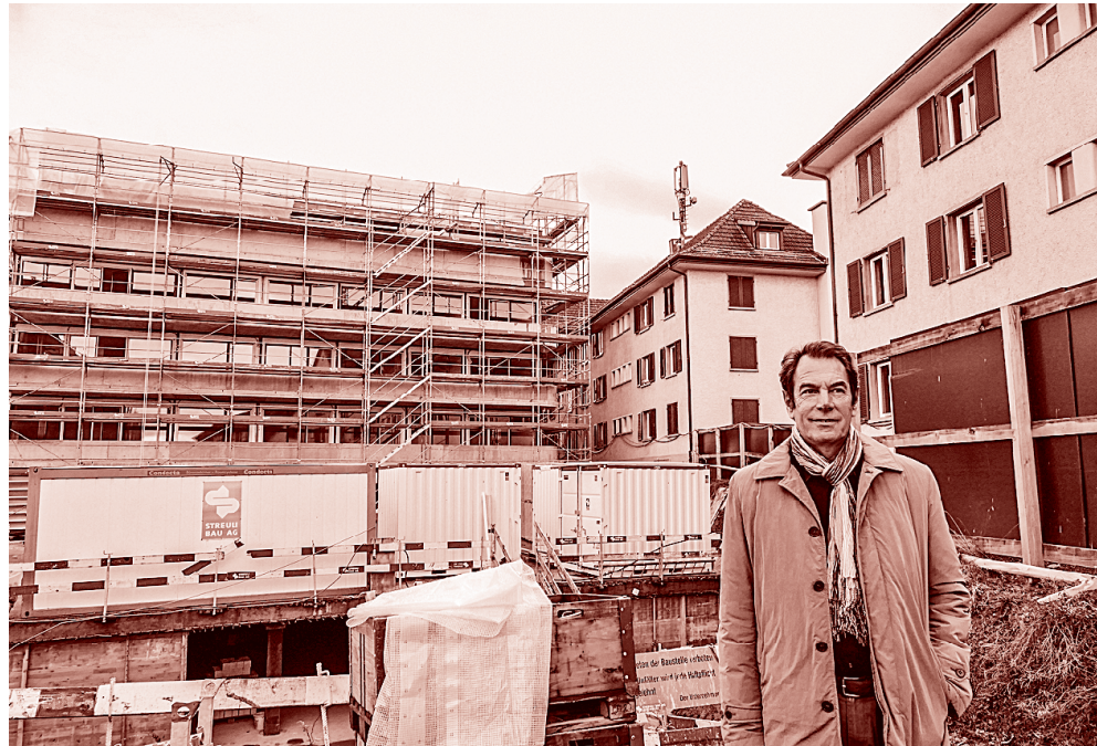
Freut sich auf der Plattenhof-Baustelle über das geplante Wohnheim: Horizonte-Geschäftsführer Erwin Wachter. Arthur Schächli
