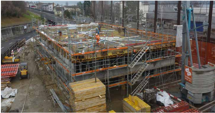
Die Bauarbeiten schreiten plangemäss voran.
